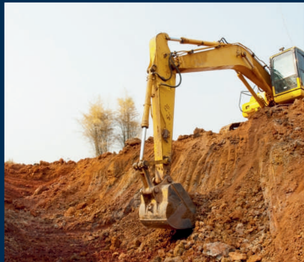
Movimiento de tierras y excavaciones
