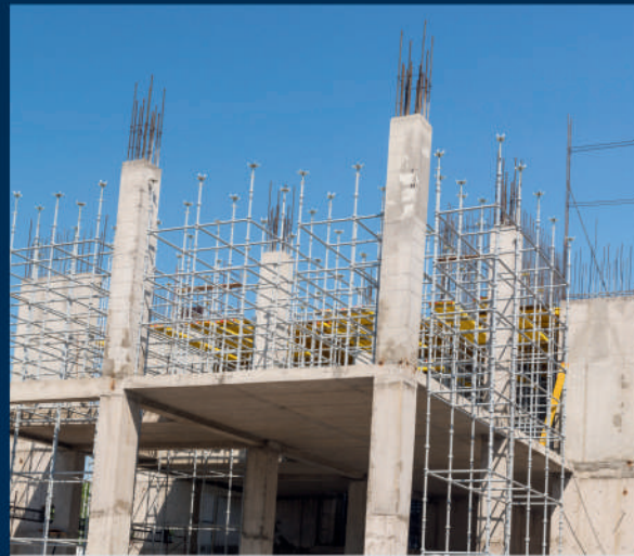
Estructuras de concreto armado
